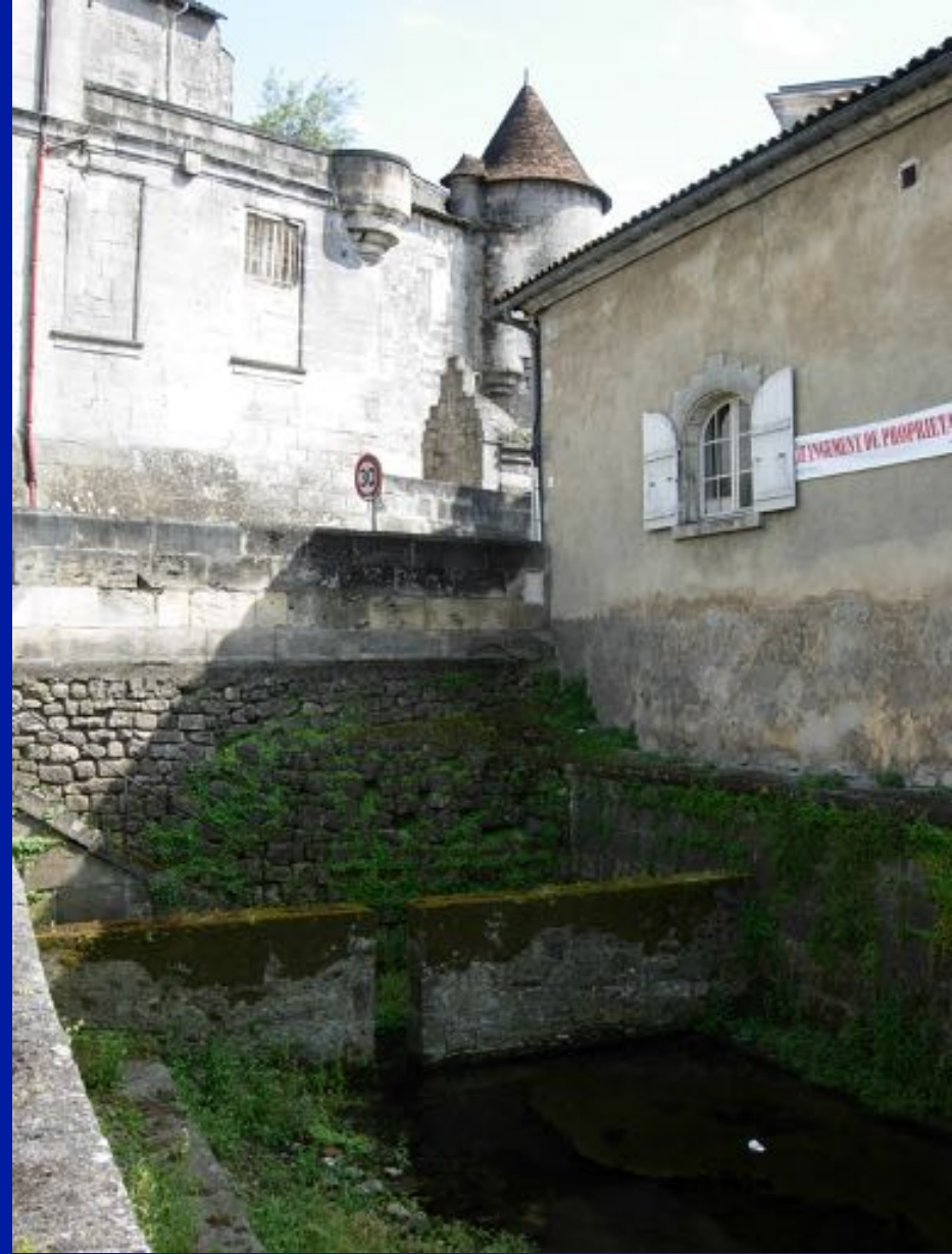
Le Creux à Charlotte avant sa restauration
