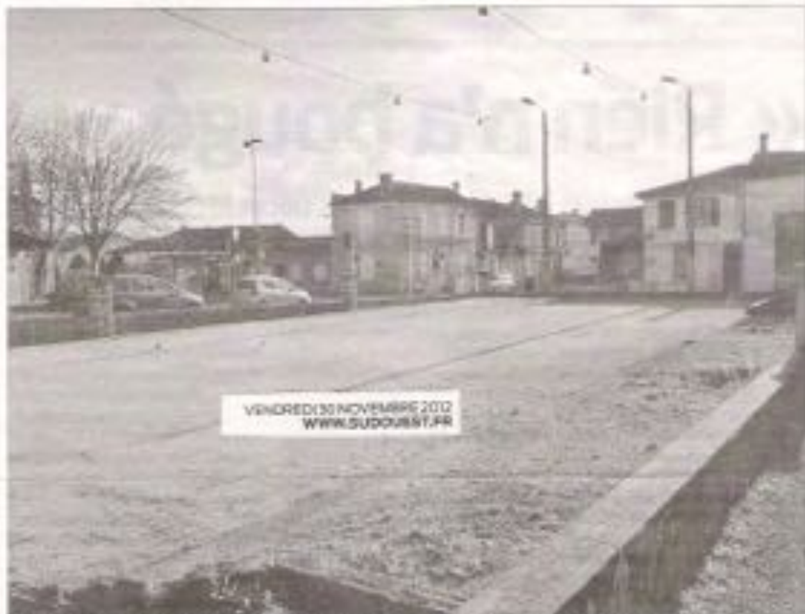
Le bassin de rétention, place du Champ-de-Foire, est toujours dans les tuyaux. >>>>>
