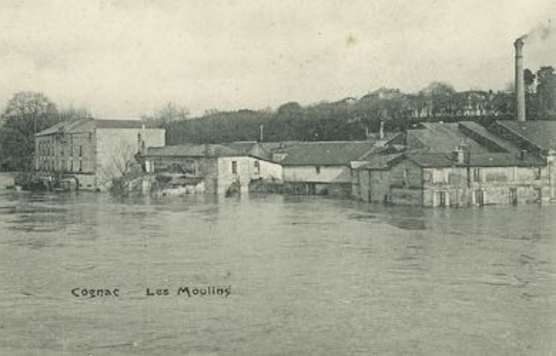
La crue de la Charente (15 Février 1904)
