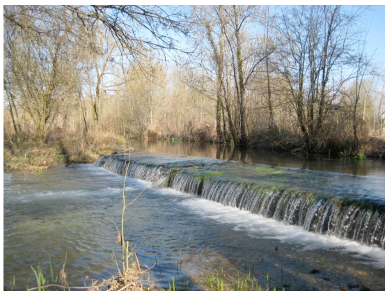
L'Antenne à la Dalle des Touches de Périgny
